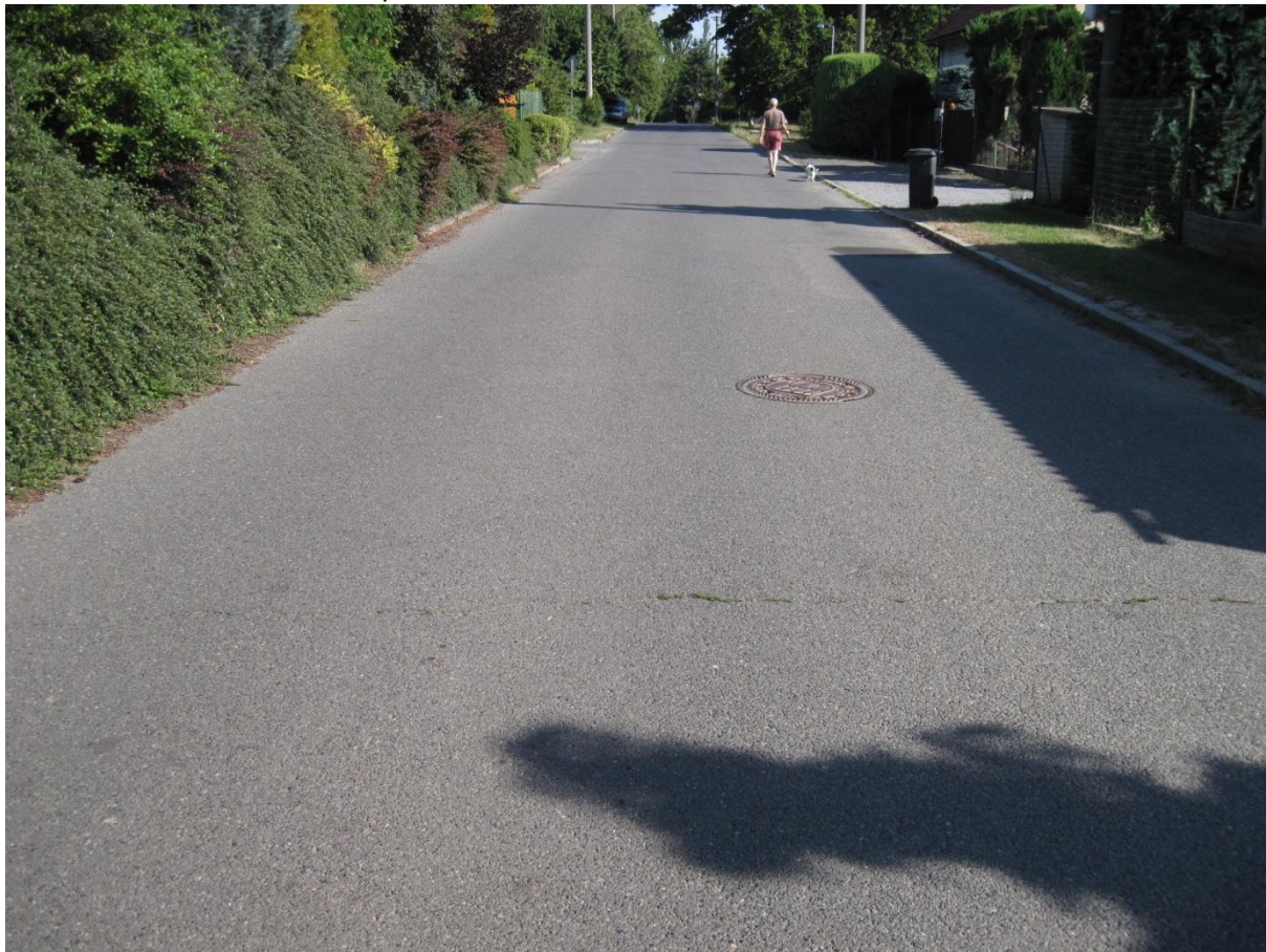
F12, km 2,230- Příčná trhlina.
