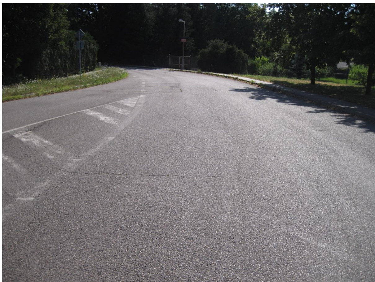
F23, km 3,660- Příčná trhlina tenká.
