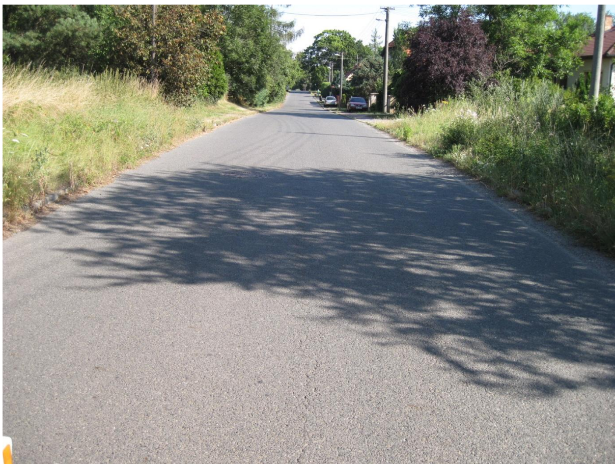
F16, km 2,330- Podélná rozvětvená trhliny uprostřed.
