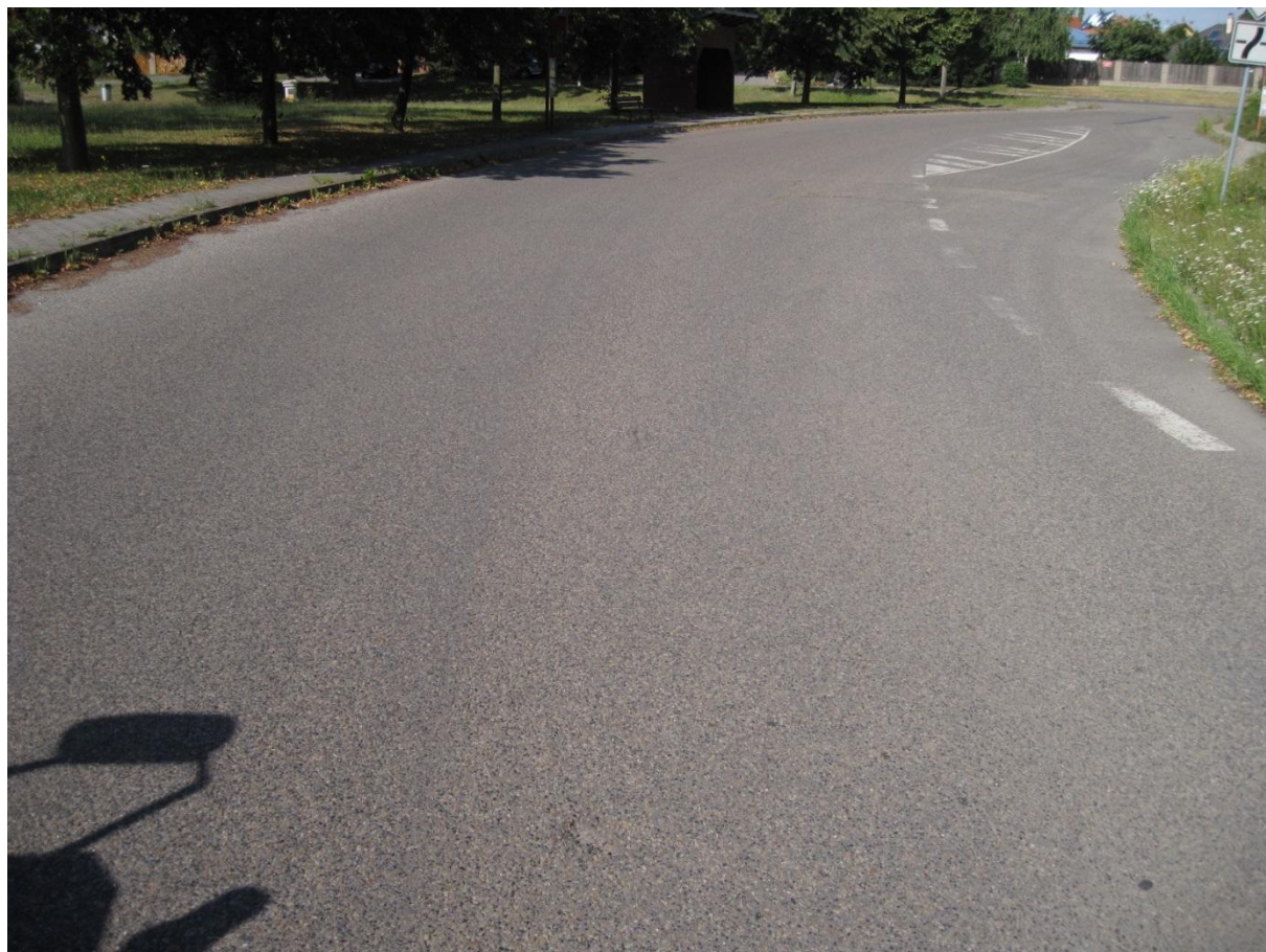
F26, km 3,610+ Ztráta asfaltového tmelu, v popředí je kaverna.
