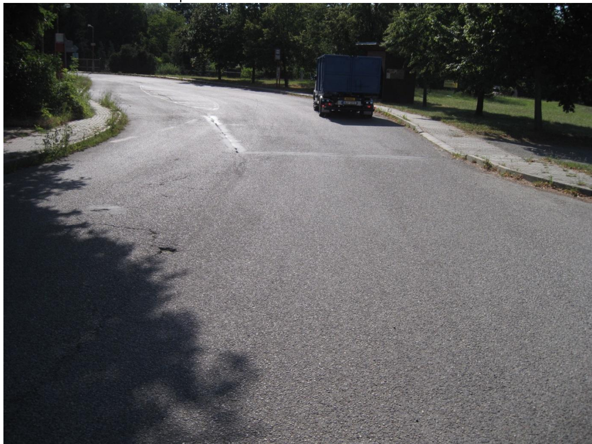
F21, km 3,700- Mozaikové trhliny, výtluk, otevřená pracovní spára.
