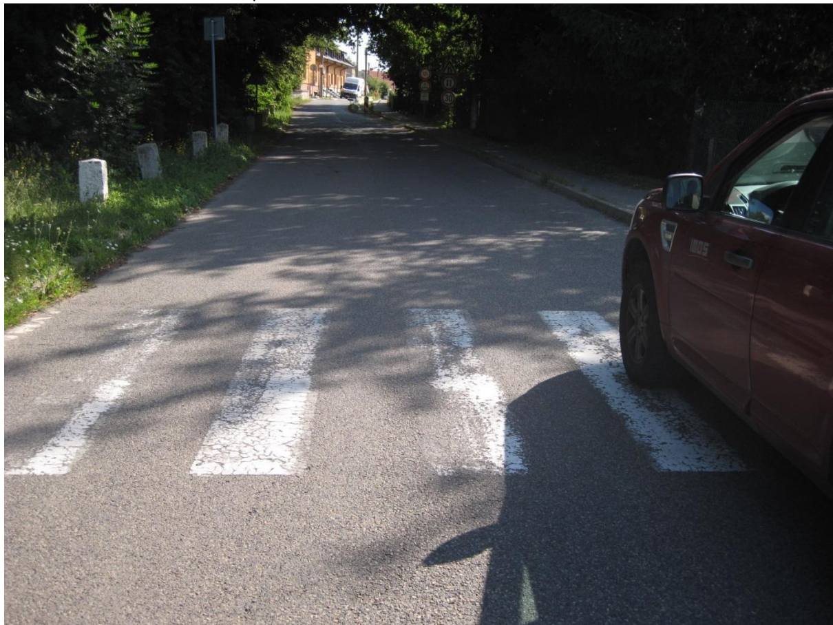
F25, km 3,610- Ztráta asfaltového tmelu.
